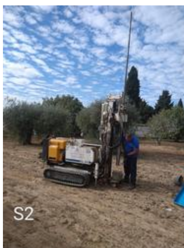
Sondeo mecánico S2
