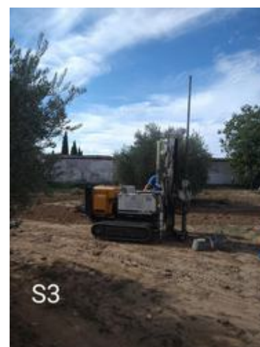
Sondeo mecánico S3
