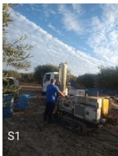
Sondeo mecánico S1
